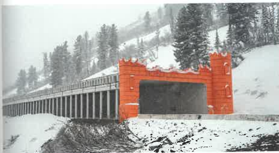
M5 Lawinenschutz für eine Straße
